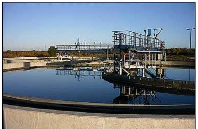
Drehbare Brücke bei einem Rundrechen
